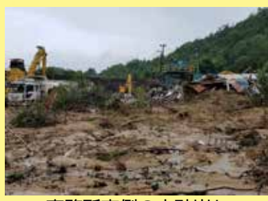
事務所南側の土砂崩れ
