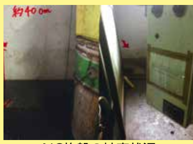
NC旋盤の被害状況
