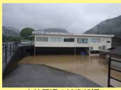
本社周辺の被害状況
