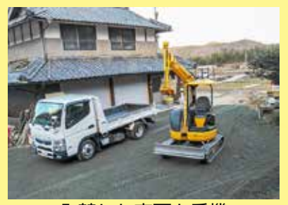
入替した車両と重機
