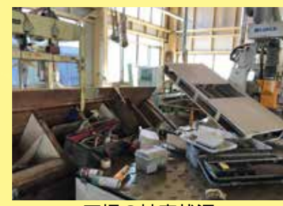
工場の被害状況
